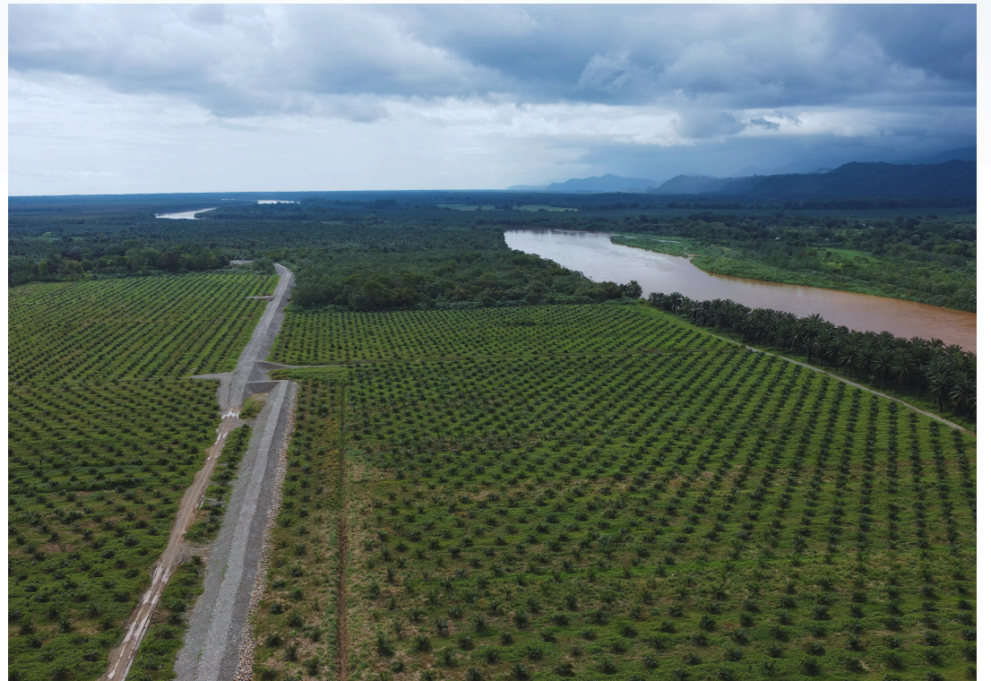
Dique de Palmar Sur de más de 10 kilómetros
