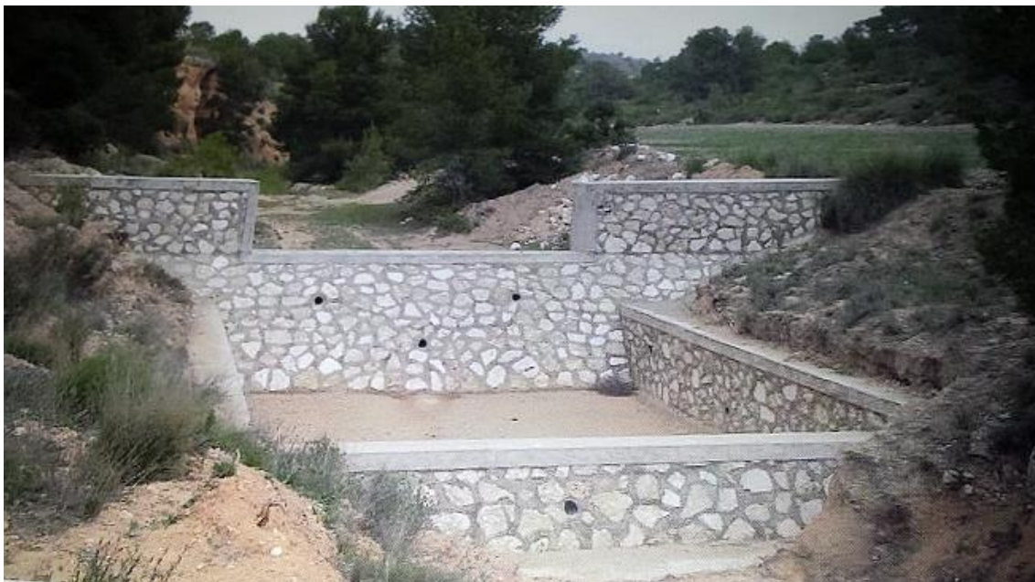
Fotografía 8 Dique construido con concreto
