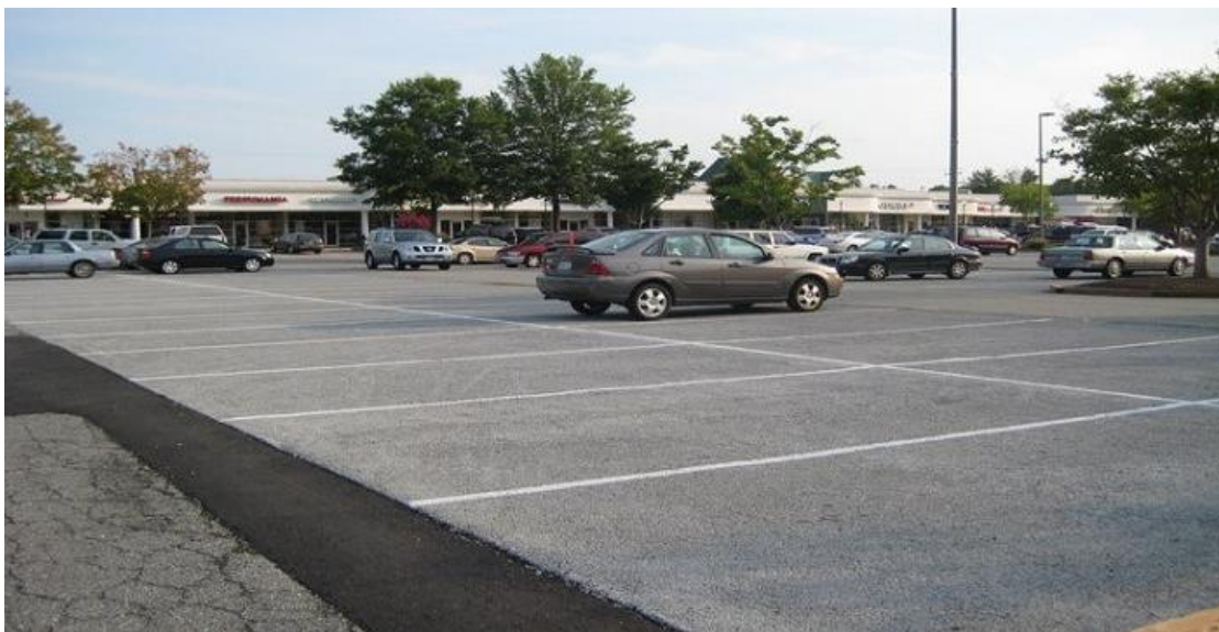
Zona de parqueo en concreto permeable
