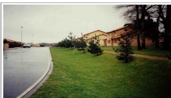
Zanja drenante en carretera Source Cete du Sud - Ouest
