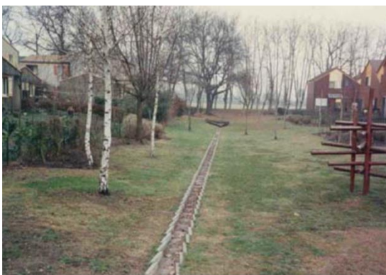
Zanja y cuneta drenante en Villaboix Bruges Source CETE du Sud-Ouest
