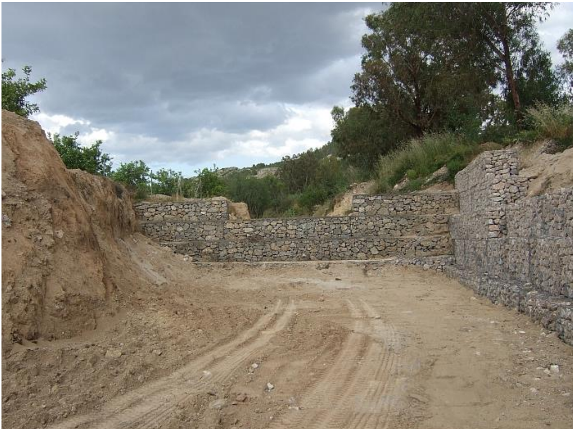
Fotografía 7 Dique construido con gaviones
